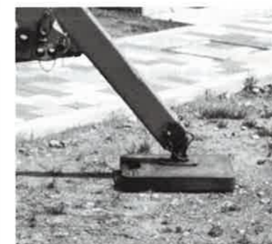
アウトリガーのフロート（先端部分）が小さいため、支持力を確保するため敷板を据える
